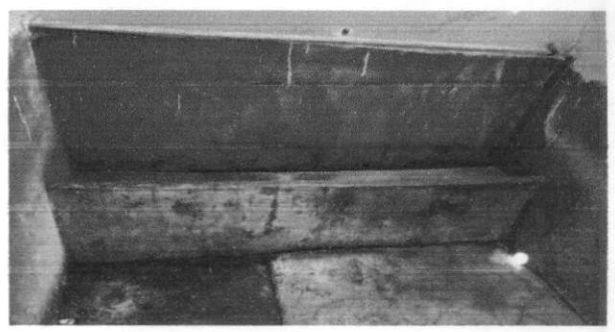
Foto 4: Sustitucion de mingitorio (uno)
