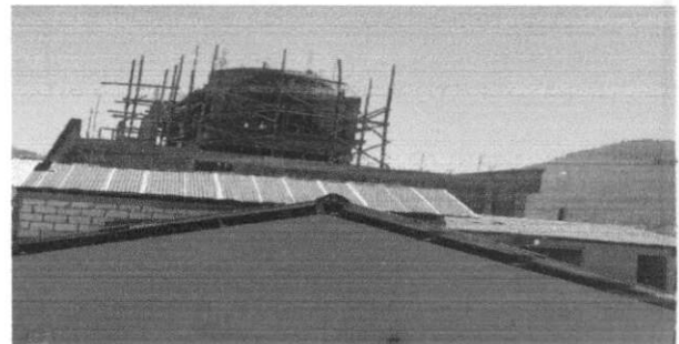
Foto 2: Sustitucion de canal de PVC, sustitucion de bajada de agua pluvial de metal por tuvo PVC y sustitucion de soporte o pescante de metal para canal.
