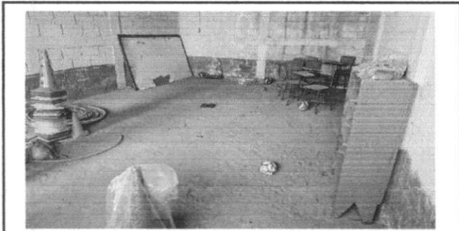
Foto 3: Sustitucion de piso de torta de concreto
