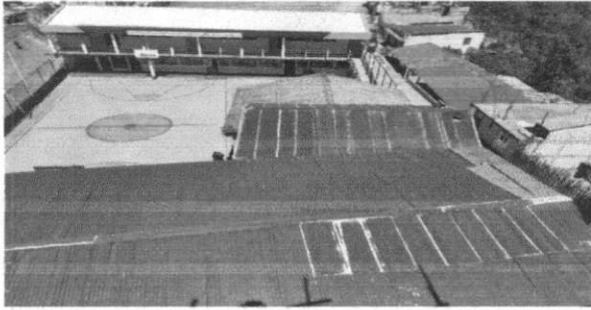
Foto 1: Sustitución de lamina por lamina troquelada, sustitución de caportes de lamina por lamina troquelada, sustitución de elementos de fijacion, sustitución de estructura de soporte de madera por metal.
